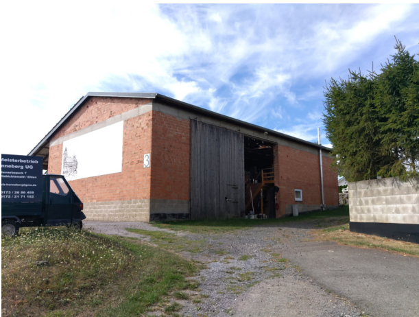
Zufahrt von der Ehringer Straße, Einfahrt ins Gebäude
