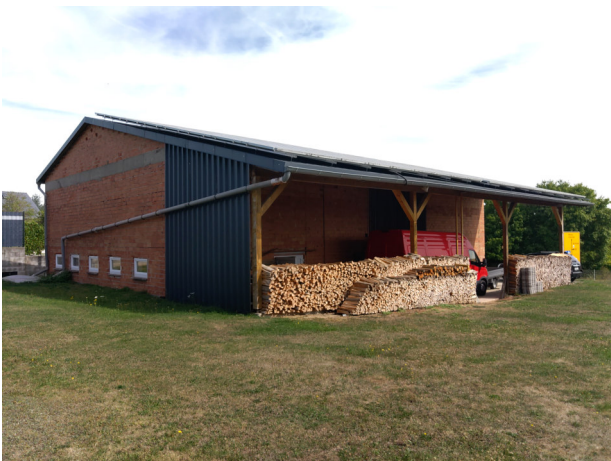
Blick von Südwesten
