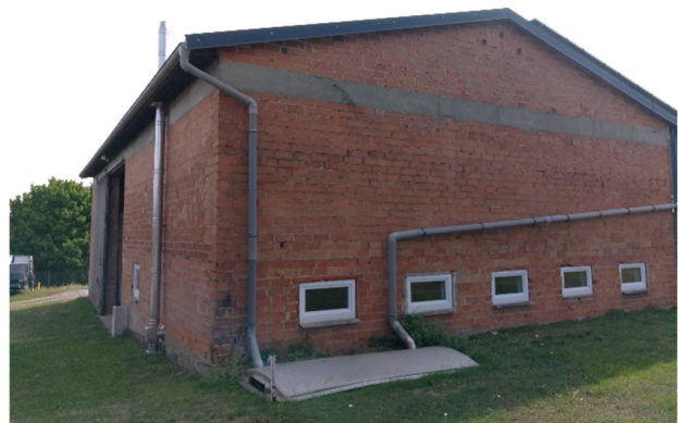
Blick von Westen (Rückseite des Gebäudes)
