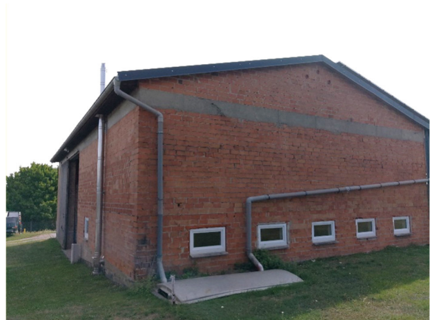
Blick von Westen (Rückseite des Gebäudes)
