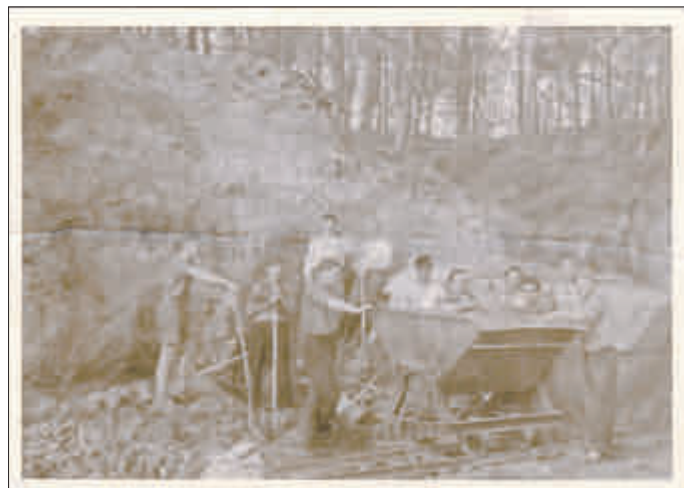
Foto von den Erdarbeiten der TSV-eigenen Sporthalle
