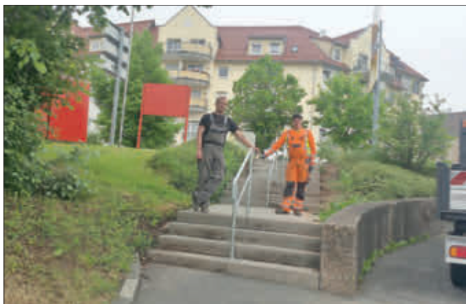
Ausführung durch Mitarbeiter des Bauhofs der Stadt Wolfhagen
