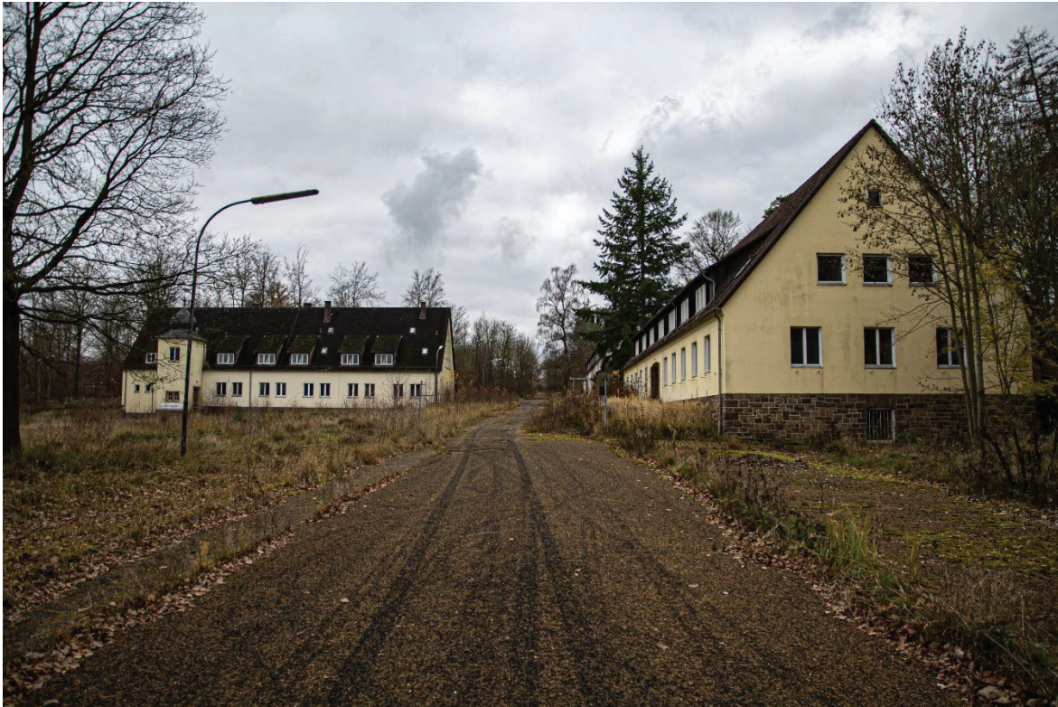
Richtung Süden - Blick auf ehm. Mannschaftsgebäude & Sanitätsgebäude – Vorwerk Gasterfeld. Verwaltungsbereich LHMa Wolfhagen (Foto: ANP)
