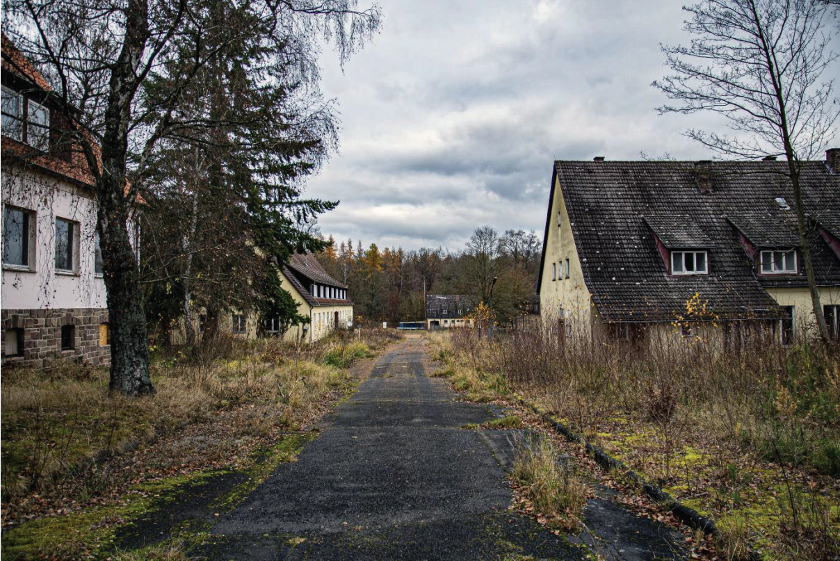
Blick in Richtung ehm. Wachgebäude – Vorwerk Gasterfeld. Verwaltungsbereich LHMa Wolfhagen (Foto: ANP)
